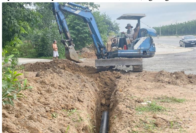
Cấp nước Gia Tân thi công lắp đặt thêm nhiều tuyến ống
