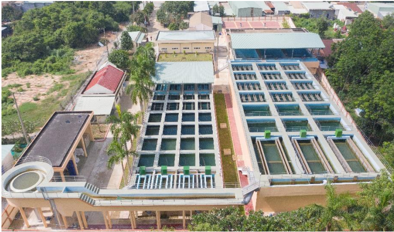
Nhà máy nước Uyên Hưng
