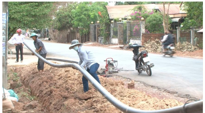
Thi công lắp đặt tuyến ống D225 mm
