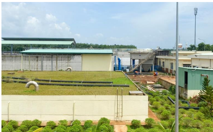
Nhà máy nước Gia Tân mở rộng tăng công suất
